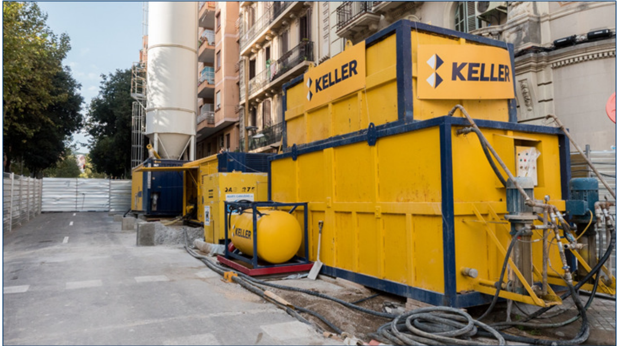
Figura 10. Disposición de planta y bombas del sistema de ejecución de Jet Grouting, en un espacio reducido en zona urbana en Barcelona.
