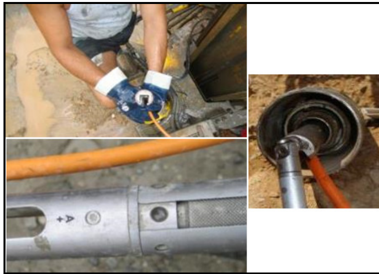
Figura 15: Control de verticalidad mediante Sistema INCLIJET®.
